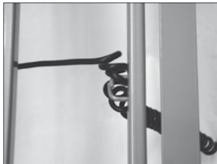
Cableado del motor de la sección de las piernas.
