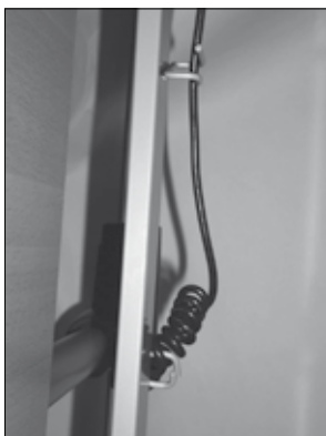
Bedrading van de hoofdsteun motor.
